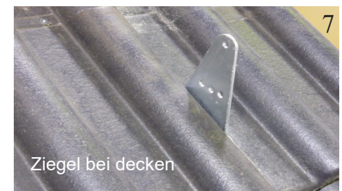
Deckelement + ca. 1cm im Bereich des Schwer-tes aussparen / schlitzen (Rasterunabhängig)
