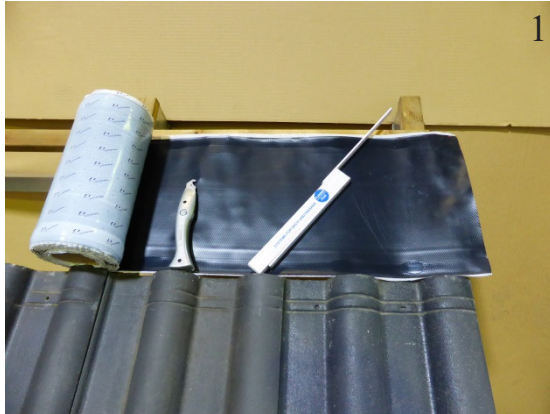
Ca. 35 cm Dichtband ablängen
