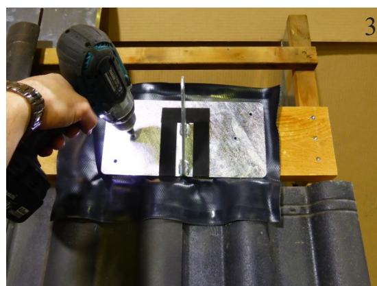
Stütze mit 6 Senkkopfschrauben 4,5 x 45mm an der Bohle befestigen.
