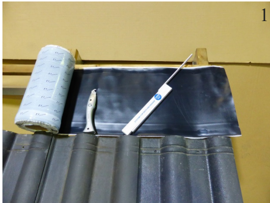
Ca. 35 cm Dichtband ablängen
