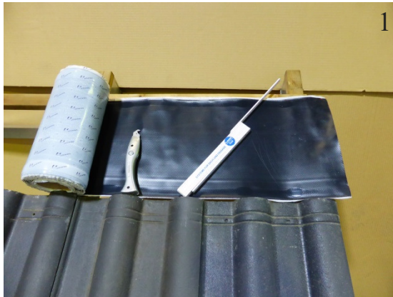
Ca. 35 cm Dichtband ablängen.
