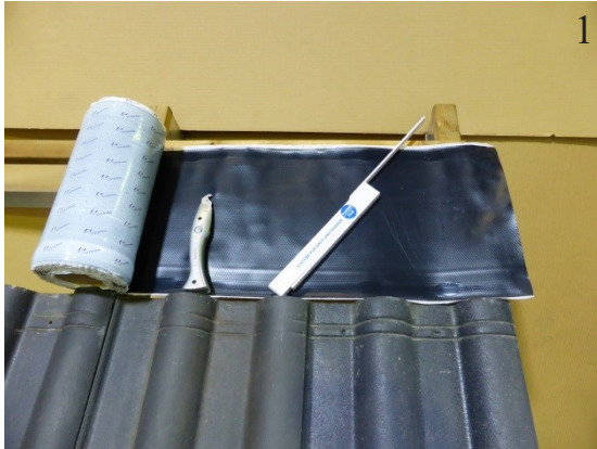
Ca. 35 cm Dichtband ablängen
