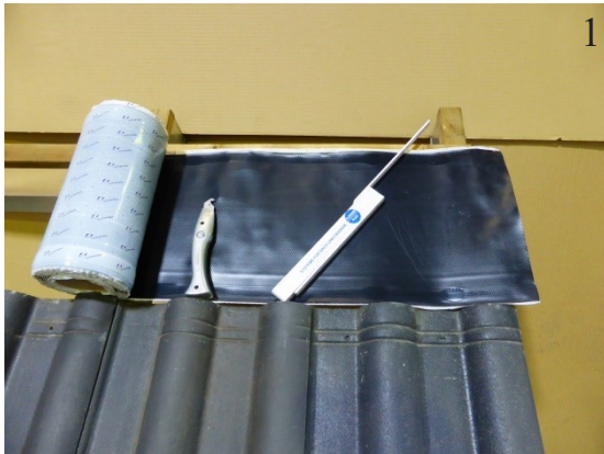
Ca. 35 cm Dichtband ablängen
