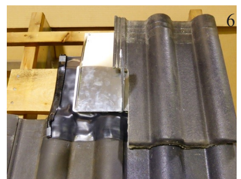
Deckelement + ca. 1cm im Bereich des Schwer-tes aussparen / schlitzen (Rasterunabhängig)
