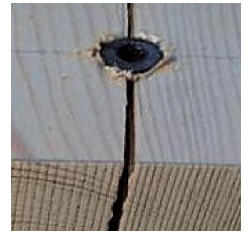
Die Einhaltung der DIN 1052 vermeidet eine Aufspaltung des Holzes
