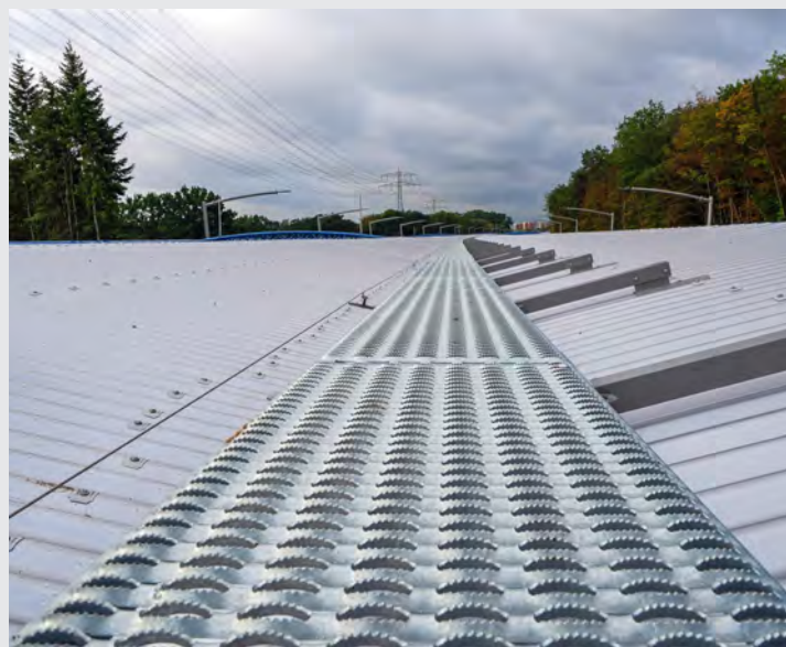
Wartungsweg Lärmschutzwände Autobahn 7 Hamburg-Schnelsen ca. 1 km Laufanlage auf Wellblechdeckung
